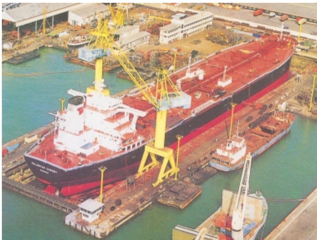
Εικόνα 3.44: Μόνιμη δεξαμενή για το δεξαμενισμό πλοίων. Μέσα στη δεξαμενή διακρίνεται ένα πλοίο.
