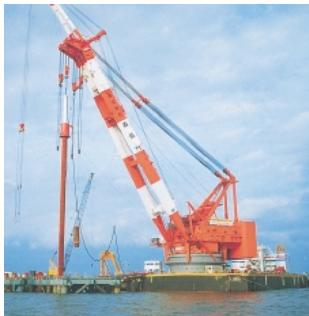
Εικόνα 3.42 (β): Πλωτός γερανός για την ανύψωση μεγάλων βαρών. Ο γερανός αυτός έχει τη δυνατότητα να σηκώνει και να κατεβάζει τη «μπούμα» και ταυτόχρονα να την μετακινεί και πλάγια, αριστερά ή δεξιά. Η συνολική ανυψωτική δύναμη αυτού του γερανού είναι 1.500 τόνοι.
