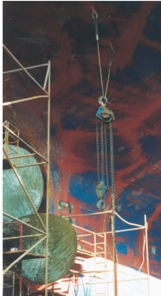
Εικόνα 11.10 (β): Διαφορετικό σύσπαστο σε λειτουργία στην πρύμη κατά το δεξαμενισμό του πλοίου.
