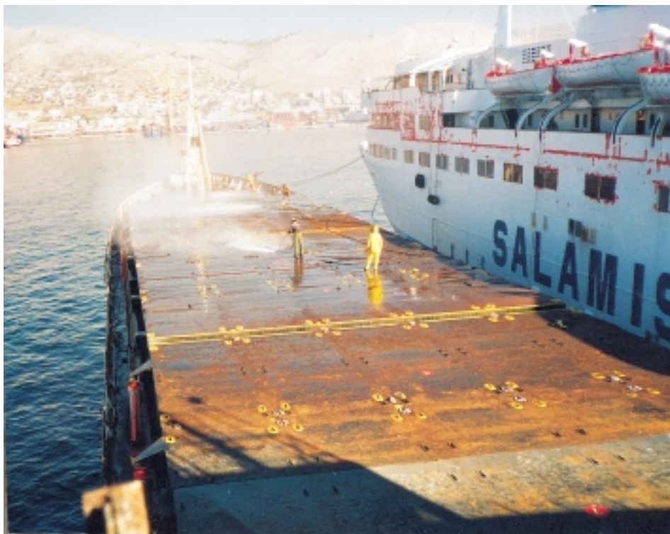
Εικόνα 13.8: Συνεργείο αφαιρεί τη σκουριά από τα καλύμματα κυτών με τη μέθοδο του water blast, δηλαδή με εκτόξευση θαλασσινού νερού με πίεση.
