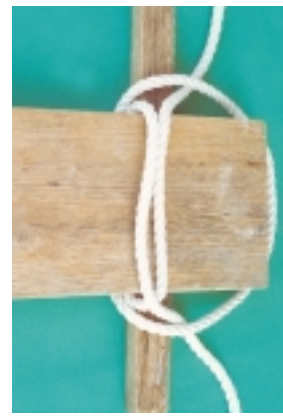
Εικόνα 7.17 (γ): Τελείωμα της σκαλωσιάς
