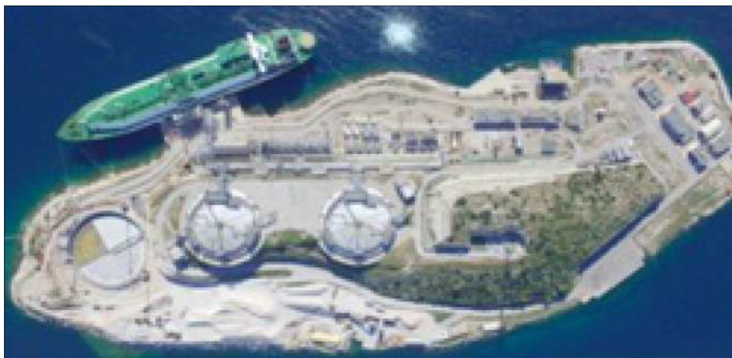
Τερματικός σταθμός Υγροποιημένου Φυσικού Αερίου της Ρεβυθούσας
