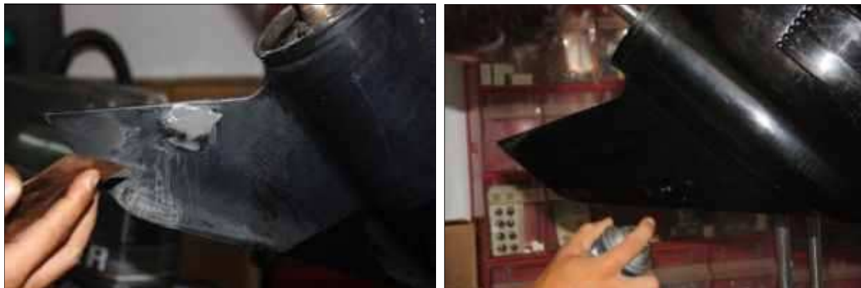
Αποκατάσταση πτερυγίου ποδιού
