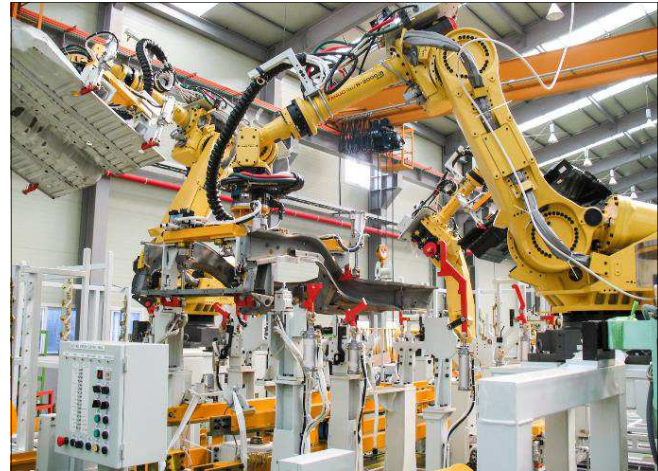
Ρομπότ σε στάδιο λειτουργίας βιομηχανικής εγκατάστασης
